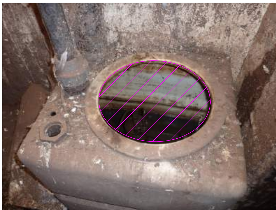
Pozzetti raccolta acque percolato area maturazione compostato
